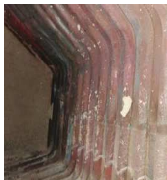
图2 锅炉水冷壁
