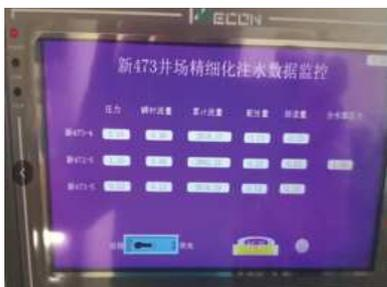
图5 阀组间注水参数控制器
